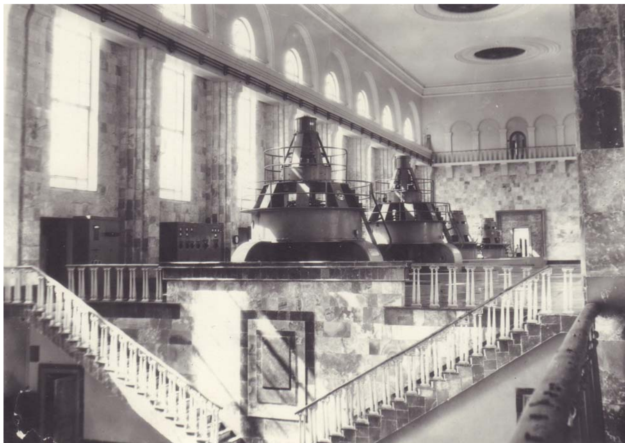
Ил. 14– Гюмушская ГЭС, интерьер генераторного зала (арх. – Т. Марутян).
