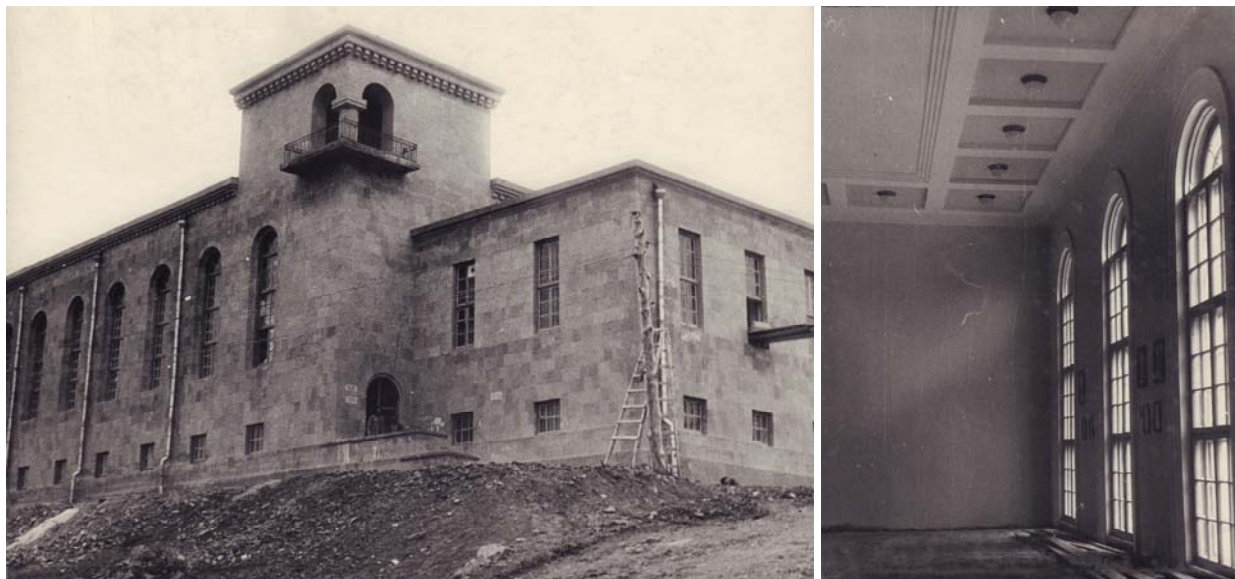
Ил. 8-9 – Севанская ГЭС, здание ЦПУ, 1946-1947 гг. (арх. - Т. Марутян)
