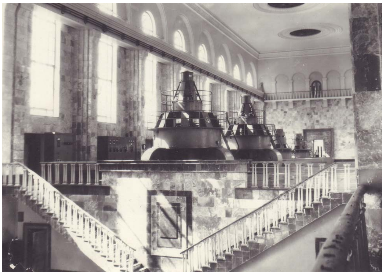
Ил. 24 – Гюмушской ГЭС, интерьер генераторного зала, 1941-1953 гг. (арх. – Т. Марутян).
