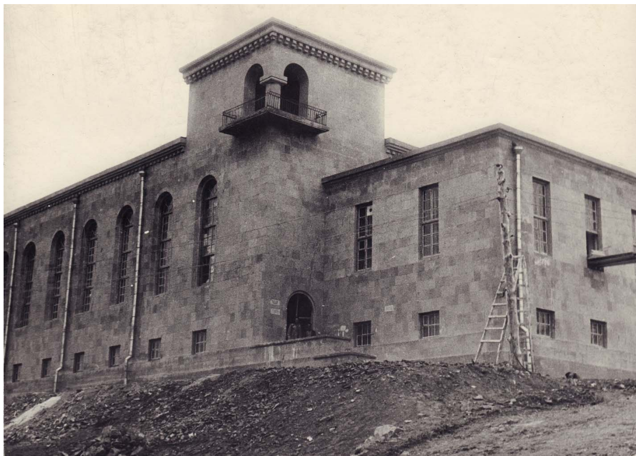
Ил. 4 – Севанская ГЭС, здание пульта управления, 1946-1947 гг. (арх. - Т. Марутян)
