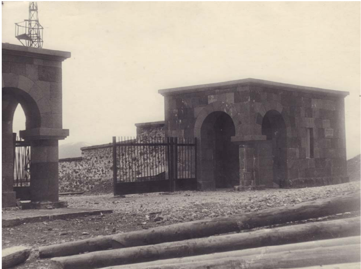
Ил. 9 – Севанская ГЭС, северный вход в надземную часть станции, 1948 г. (арх. - Т. Марутян).
