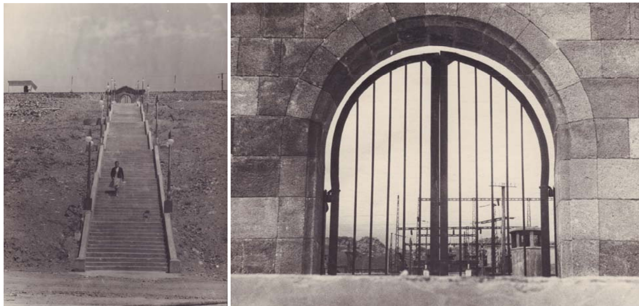
Ил. 7-8 – Севанская ГЭС, лестницы и южный вход в надземную часть станции, 1948 г. (арх. - Т. Марутян).
