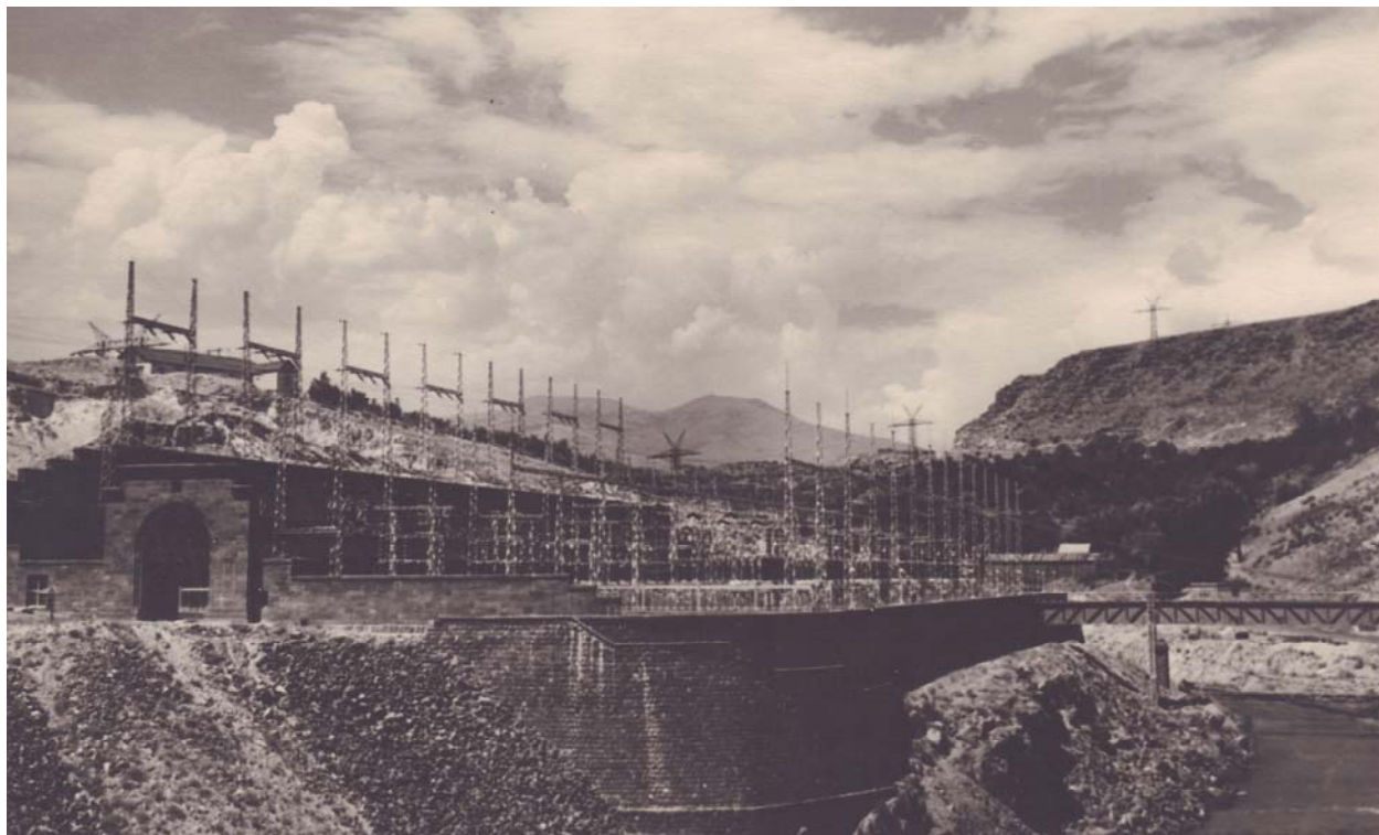
Ил. 27 – Гюмушской ГЭС, открытая подстанция, 1952 г. (арх. – Т. Марутян).
