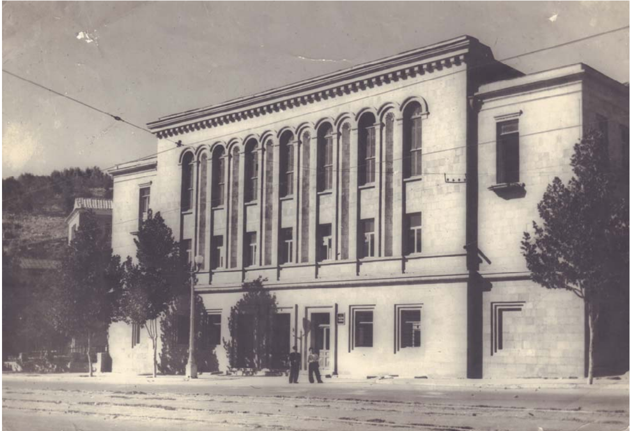
Նկ. 1 – Կոռպորատիվ տեխնիկումի շենքը Կորյունի փողոցի վրա, 1938-1943 թթ. (այժմ՝ պոլիտեխնիկական համալսարանի մասնաշենք N 12, ճարտարապետ՝ Տ. Մարության):
